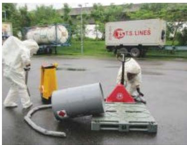
搶救班-執行桶身破裂處止漏作業
